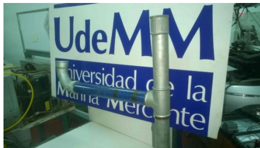
Fig.12. Conducto conectado al ventilador
